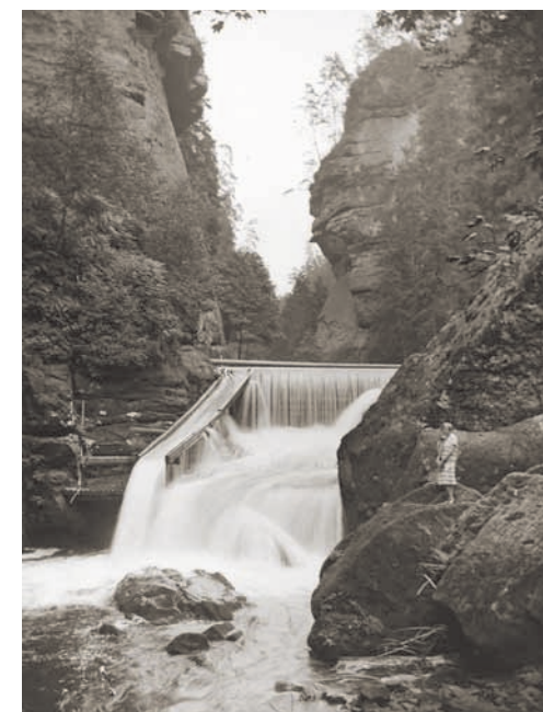
Divoká soutěska s konstrukcí pro splavování dříví.
