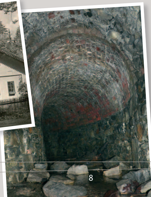
Spojovací štola staré a nové jámy
