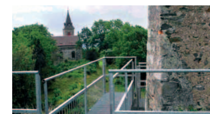
Zpřístupnění hradu Švamberk pochozími kovovými rošty. Foto: Jiří Belis
