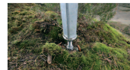
Osazení stojek pod lávkami se zachováním krytí vegetace. Foto: Václav Sojka
